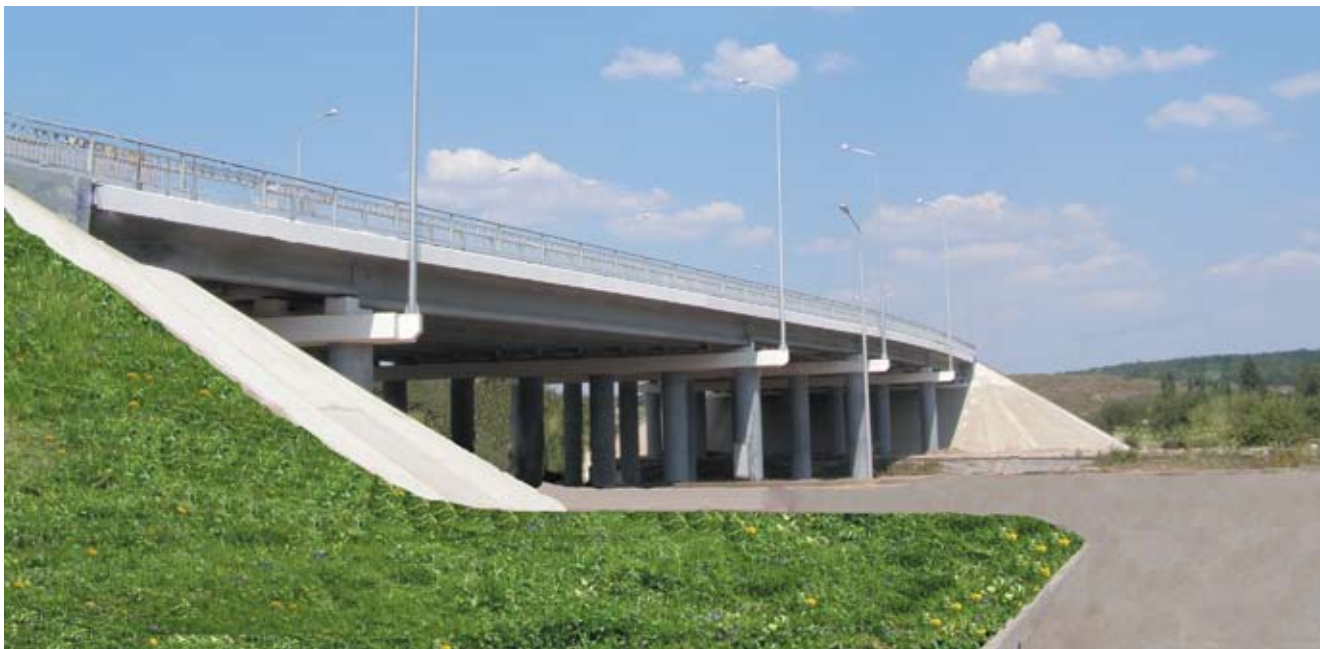
Путепровод на ПК 61+57 магистральной а/д «Спутник-Сумская-Чичерина-ротонда» в г. Белгороде
