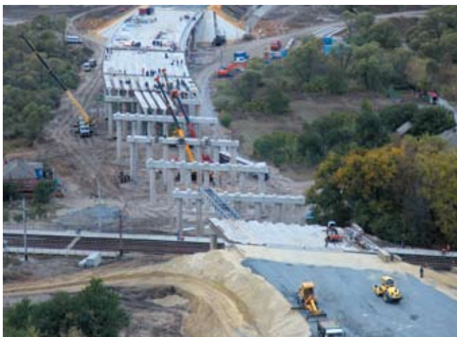
Строительство эстакады на ПК 2+66 магистральной а/д «Спутник-Сумская-Чичерина-ротонда» в г. Белгороде
